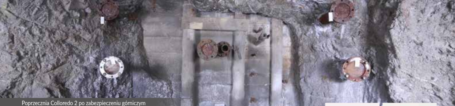
Poprzeczna Colloredo 2 po zabezpieczeniu górniczym
